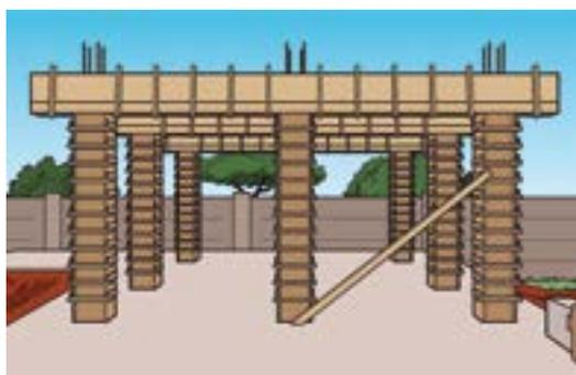
As formas de madeira podem ser executadas basicamente com dois tipos de madeira: madeira serrada e placas de compensado. A escolha do material é feita pelo construtor, de acordo com as características de cada obra.
