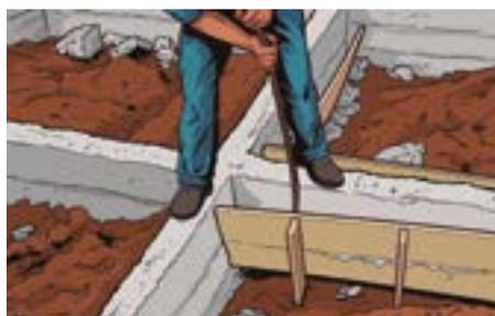
A desforma somente deve ser realizada após o prazo necessário para que o concreto obtenha a resistência e o módulo de elasticidade necessários. Caso não existam indicações específicas, e a critério da fiscalização, devem ser adotados, para o concreto comum os seguintes prazos mínimos:
